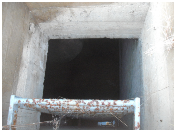
Figura 4: Pozzetto di ispezione
