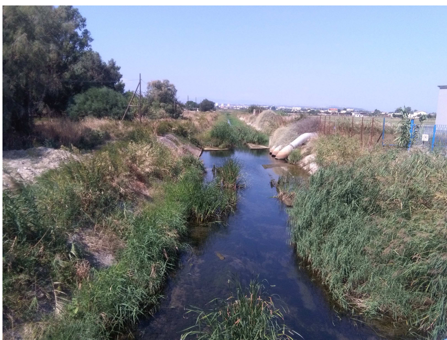
Figura 6 – Canale C7. Mandracchio di valle. Vista dal ponte di Via San Giusto.
