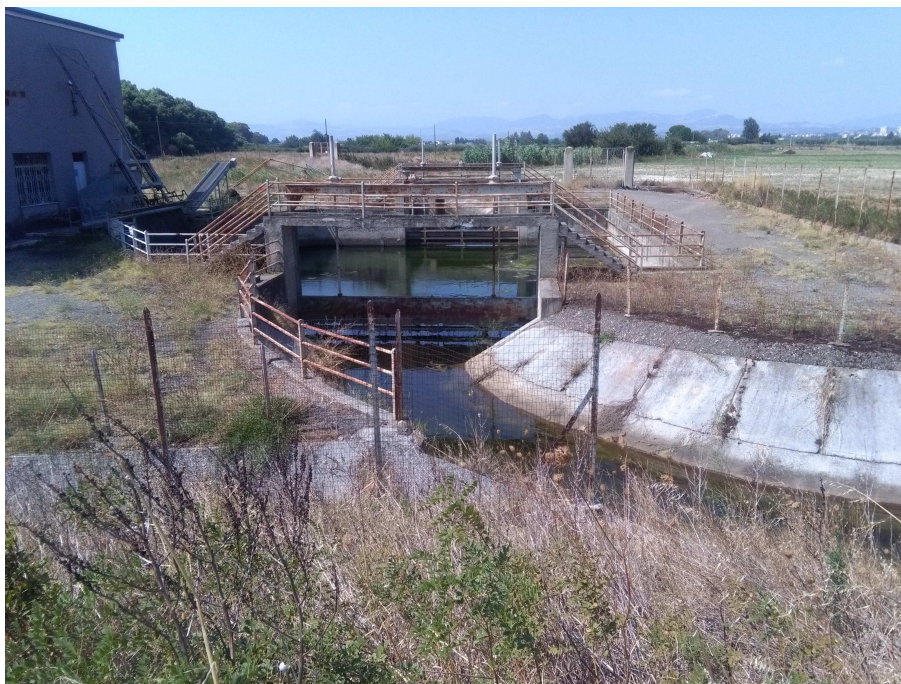
Figura 5 – Mandracchio di monte. Vista da Via San Giusto. Arrivo Canale C8 e Canale C9.
