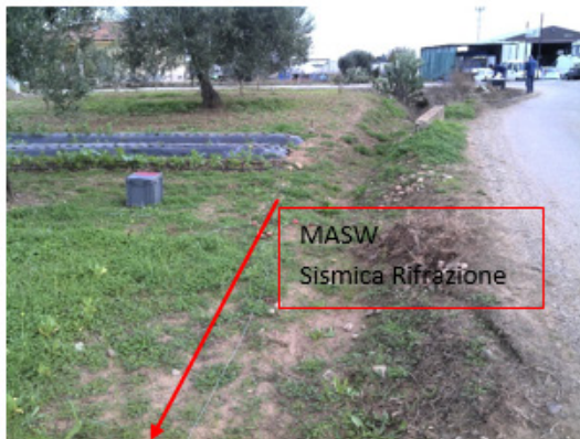
MASW 2, SISMICA A RIFRAZIONE
